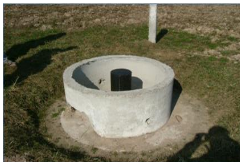
Рис. 6.2. Колодец-поглотитель (крышка снята)
