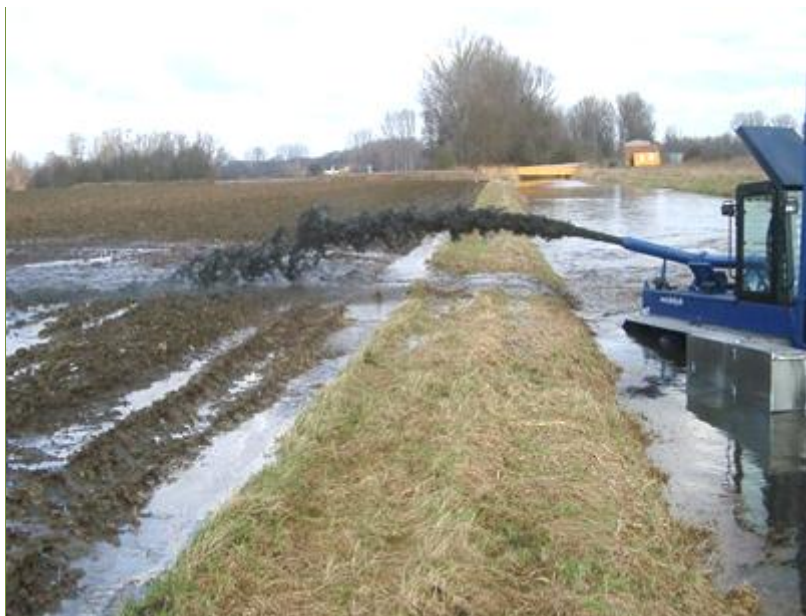
Рис. 5. Вид работы земснаряда-амфибии с выбросной трубой
