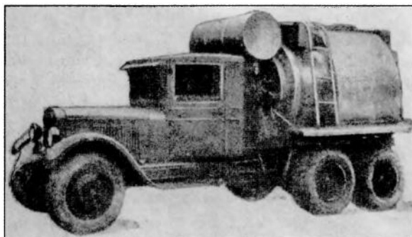
Рис. 5.22. Первый советский серийный автобетоносмеситель CCCM-738/C-49
