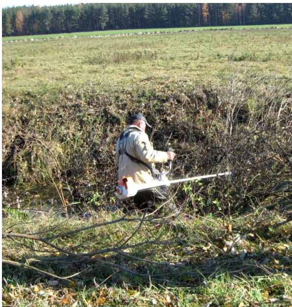
Рис. 5.2. Сводка древесно-кустарниковой растительности кусторезами «Хускварна».
