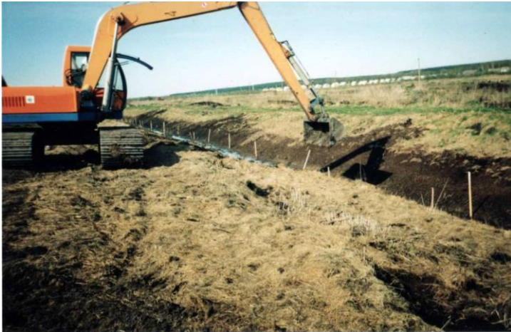
Рис. 5.10. Очистка канала от наносов экскаватором ЭО-3223.
