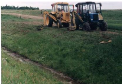
Рис. 5.6. Окашивание растительности на откосах и бермах каналов.
