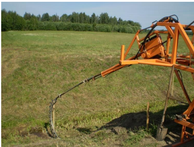
Рис. 5.24. Промывка дренажных коллекторов с применением направляющего устройства.
