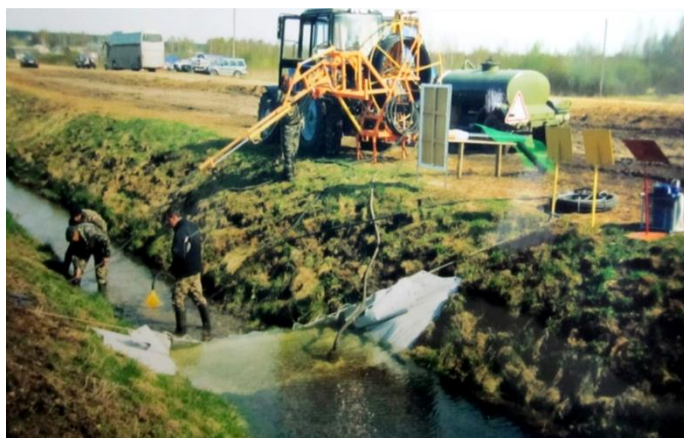
Рис. 5.20. Промывка дрен и коллекторов от наносов
