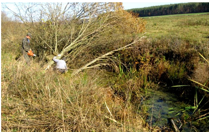
Рис. 5.3. Валка деревьев на откосах каналов бензопилами.
