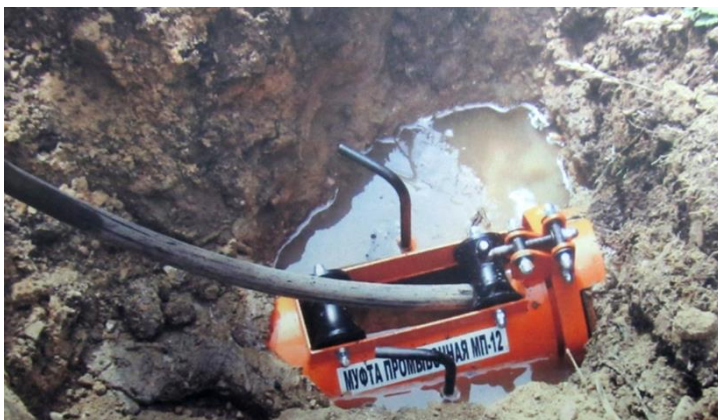
Рис. 5.22. Муфта промывочная МП-12.
