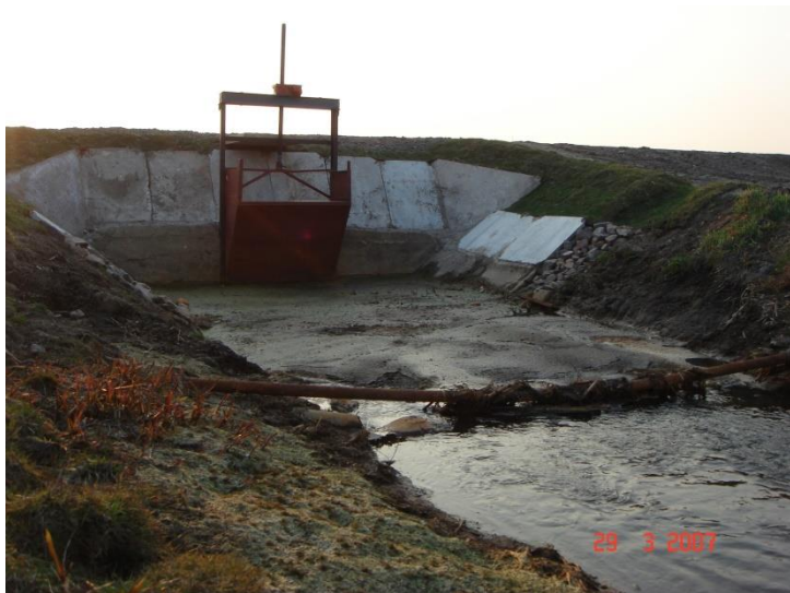
Рис. 3.4. Скопление бузы перед трубой-регулятором.
