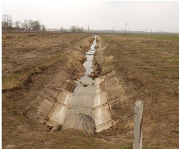
Рис. 3.2. Размыв канала потоком воды.
