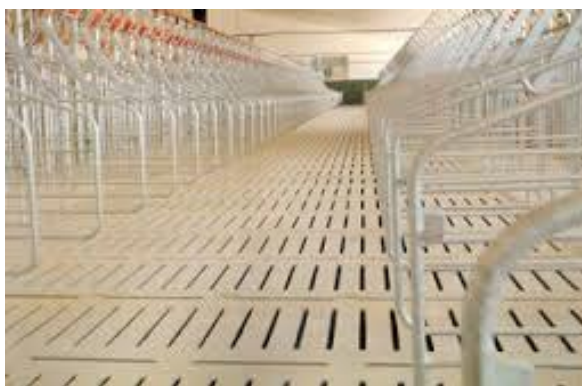
Рис. 29. Устройство полов в свинарниках
