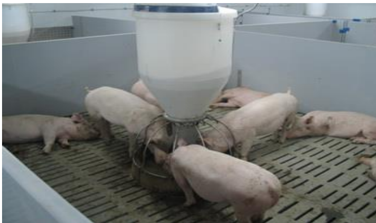
Рис. 32. Бетонные щелевые полы
