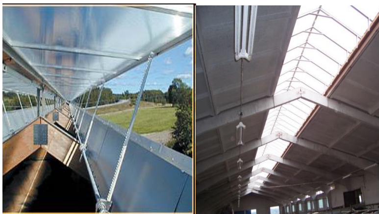
Рис. 28. Вентиляционный и светоаэрационный конек
