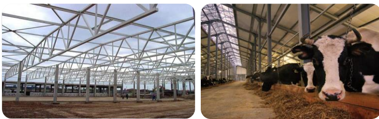
Рис.9. Помещения из металлоконструкции
