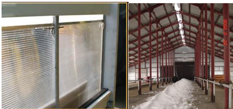
Рис. 30. Подвижные панели из поликарбоната для вентиляции коровника
