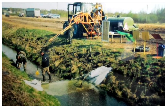
Рис. 22. Промывка дрен и коллекторов от наносов дренопромывочной машиной УПД-120.
