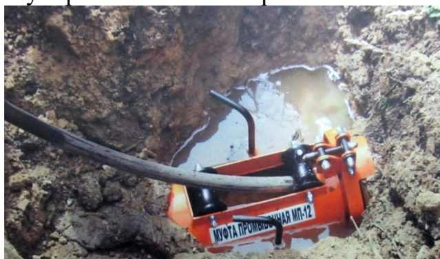
Рис. 11.22. Муфта промывочная МП-12.
