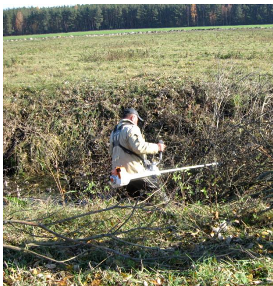
Рис. 11.2. Сводка древесно-кустарниковой растительности кусторезами «Хускварна».
