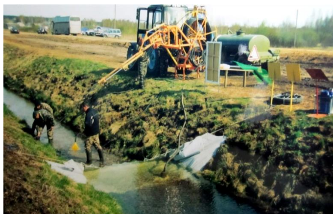
Рис. 11.20. Промывка дрен и коллекторов от наносов дренопромывочной машиной УПД-120.
