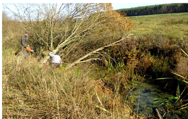
Рис. 11.3. Валка деревьев на откосах каналов бензопилами.
