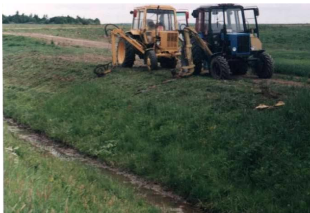
Рис. 11.6. Окашивание растительности на откосах и бермах каналов.
