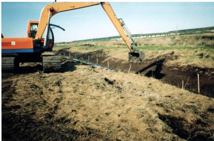
Рис. 11.10. Очистка канала от наносов экскаватором ЭО-3223.
