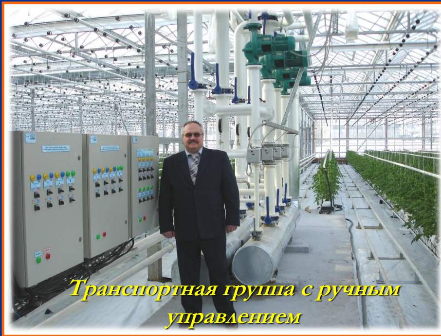
Щит обогрева и контроллер управления микроклиматом
