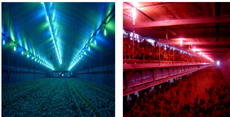
Рис. 21. Система освещения Gasolec Orion: а – сине-зеленая для бройлеров; б – красная для несушек
