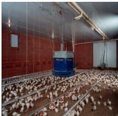
Рис. 18. Система обогрева «Хит-Мастер»
