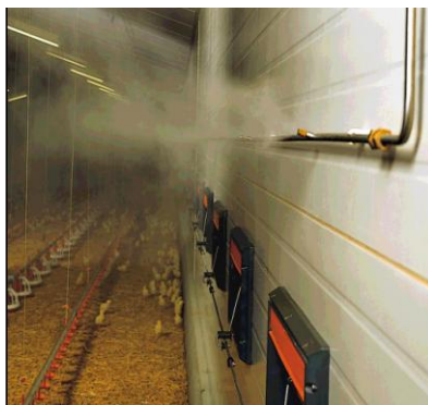
Рис. 19. Система увлажнения с форсунками высокого давления
