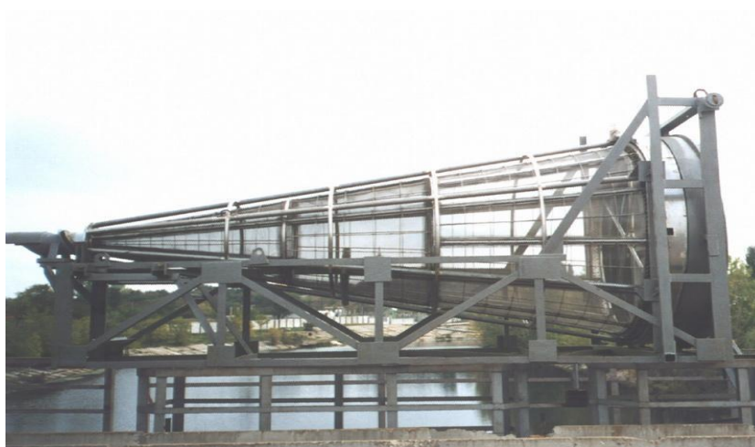
Рис. 7.2.11. Рыбозащитное устройство с конусообразной защитной сеткой на водозаборе Приволжской оросительной системы
