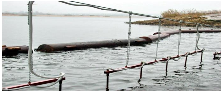
Рис. 7.2.12. Рыбозащитное устройство типа «униполярный электрорыбозаградитель» для береговой насосной станции Сормовской ТЭЦ
