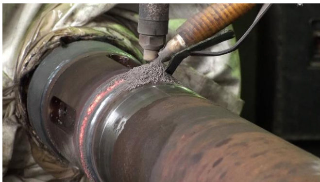
Рис. 4. Процесс восстановления вала наплавкой под слоем флюса
