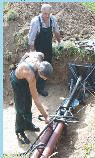
Прокалывающая установка ПУ-2 производства ОАО "Михневский РМЗ"
