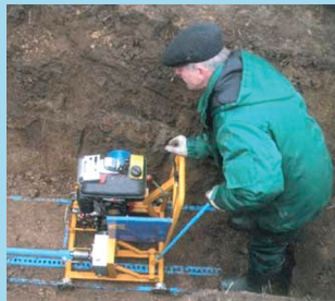
Установка горизонт. бурения УГБ-2
