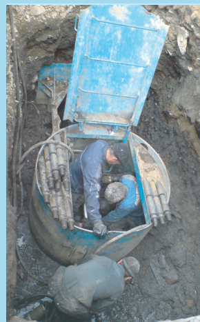
Установка направленного прокалывания УНП- 630 Диаметр прокола - до 630 мм, Длина прокола - до 100 м
