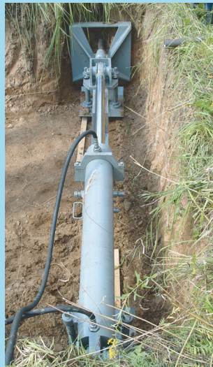
Прокалывающая установка ПУ-2 производства ОАО "Михневский РМЗ"
