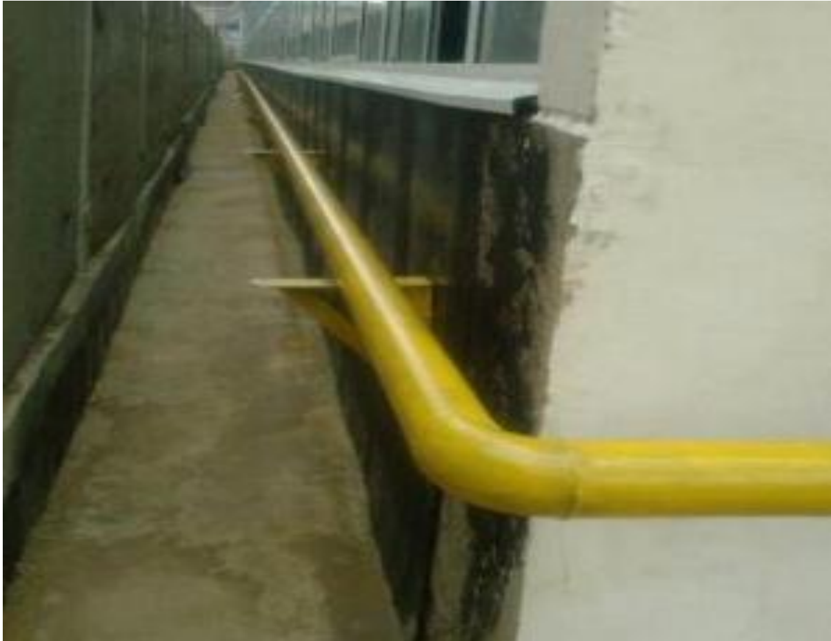
Прокладка теплопроводов на кронштейнах
