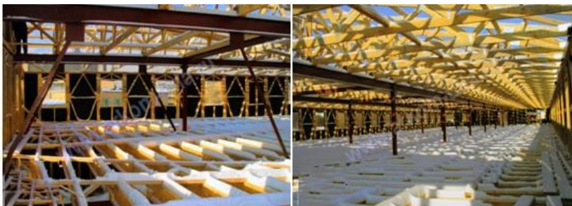
Рис. 28. Металлодеревянные фермы
