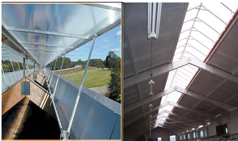
Рис. 46. Вентиляционный и светоаэрационный конек
