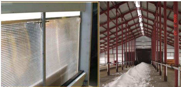
Рис. 48. Подвижные панели из поликарбоната для вентиляции коровника
