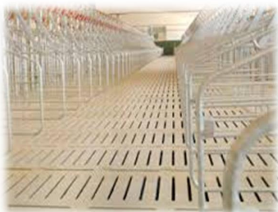
Рис. 2. Устройство полов в свинарниках
