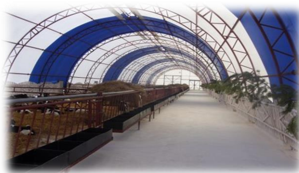
Рис. 18. Каркасно-тентовое помещение для коров Рис. 19 - Содержание телят в ангаре на глубокой подстилке
