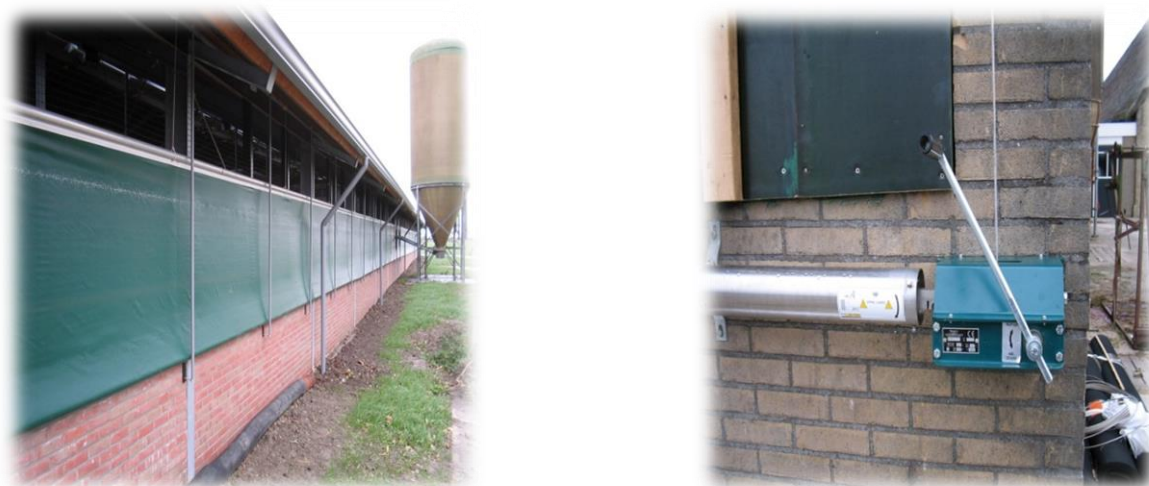
Рис. 16. Шторная система вентиляции в коровнике с автоматическим управлением
