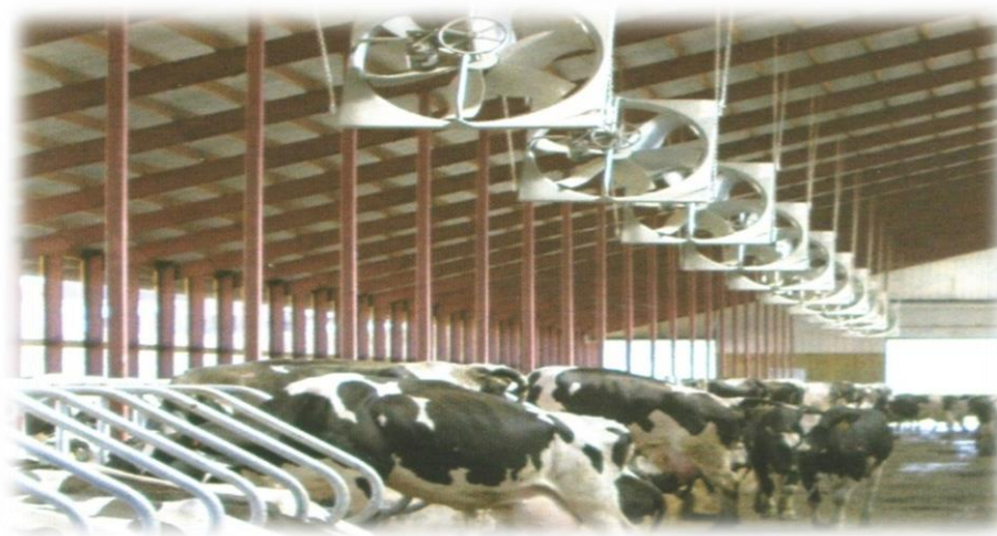
Рис. 17. Искусственная вентиляция в коровнике
