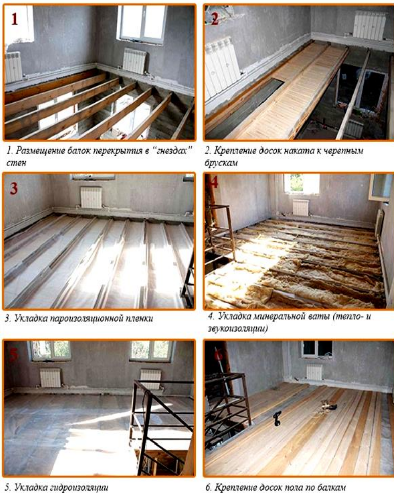
Рис. 67. Устройство перекрытия по деревянным балкам
