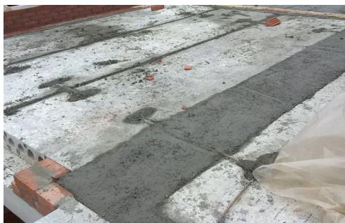
Рис. 61. Монолитный участок сборного железобетонного перекрытия
