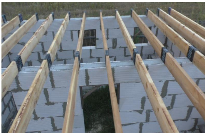
Рис. 65. Установка деревянных балок с гидроизоляцией опорных участков
