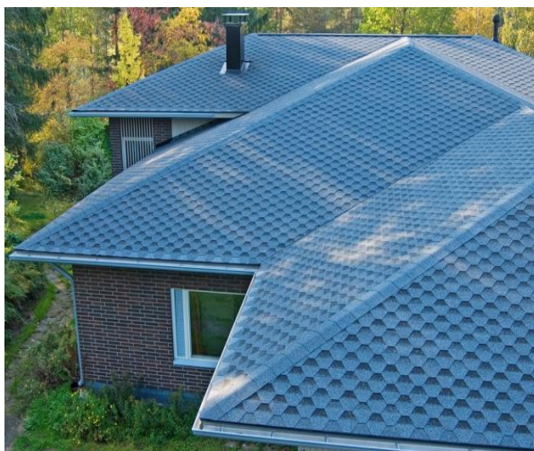
Рис. 119. Кровля из битумной черепицы
