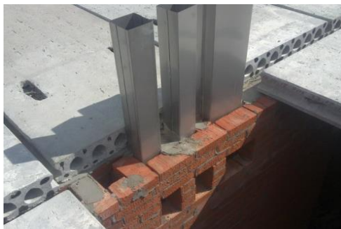
Рис. 60. Пропуск вентиляционных каналов через сборное железобетонное перекрытие
