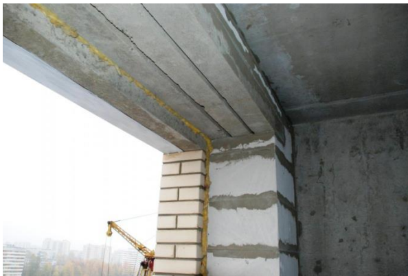
Рис. 74. Верхний простенок над оконным проемом
