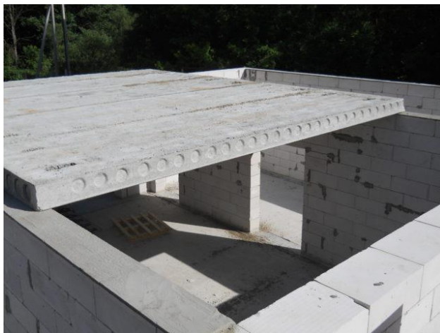
Рис. 53. Сборное железобетонное перекрытие из плит железобетонных круглопустотных
