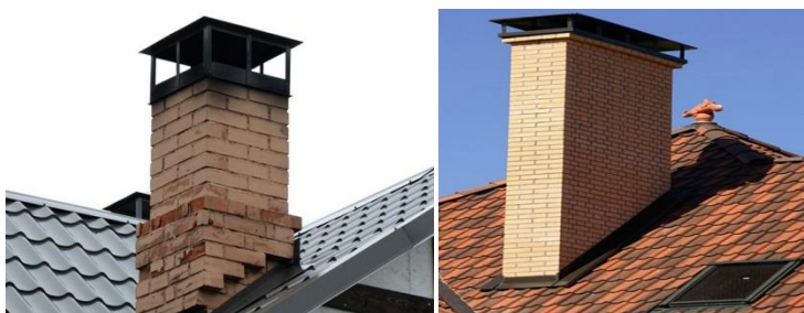
Рис. 22. Пример дымовой и вентиляционной труб
