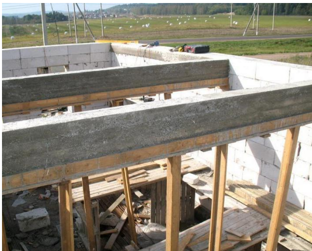
Рис. 59. Устройство железобетонных балок перекрытия на месте строительства
