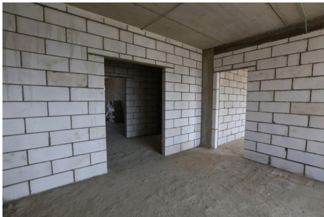
Рис. 24. Межкомнатные перегородки из газобетона
