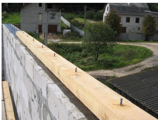
Рис. 94. Установка мауэрлата на наружную стену
