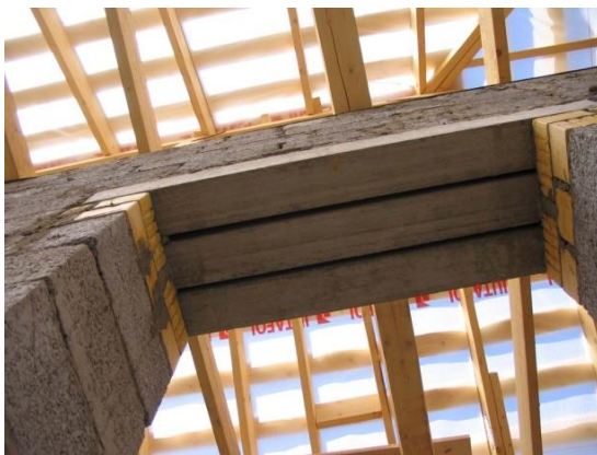
Рис. 79. Брусковые перемычки над дверным проемом
