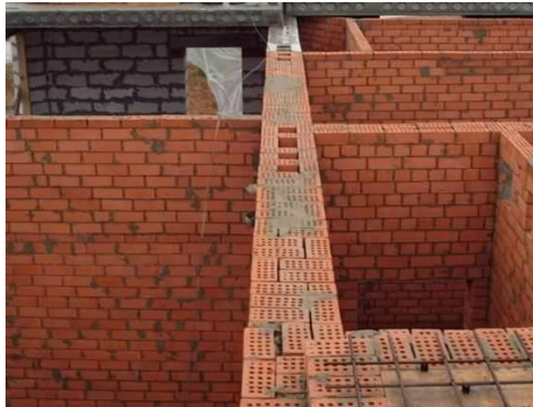
Рис. 17. Внутренняя стена жилого дома с вентиляционными каналами
