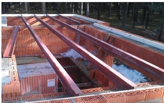
Рис. 58. Устройство перекрытия по металлическим балкам
