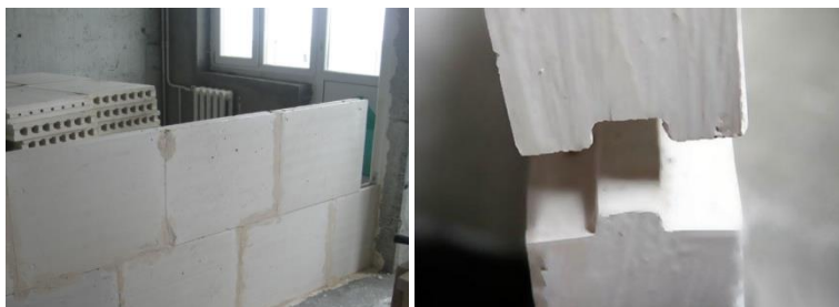
Рис. 25. Межкомнатные перегородки из пазогребневых гипсовых плит
