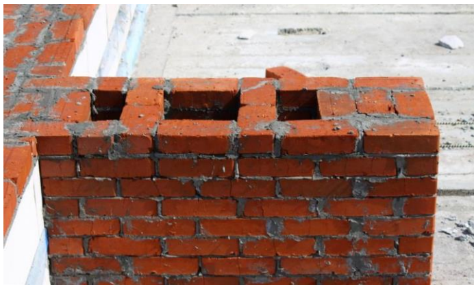
Рис. 20. Вентиляционный стояк жилого дома
