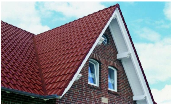
Рис. 110. Кровля из керамической черепицы
