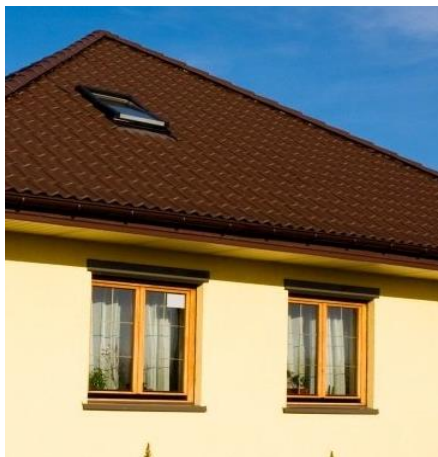
Рис. 70. Окна в стене и крыше дома
