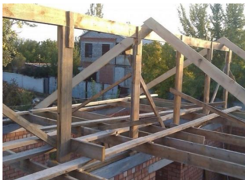
Рис. 95. Установка прогона
