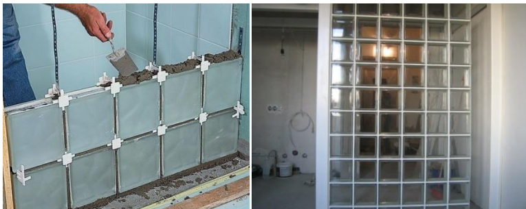
Рис. 27. Перегородки из стеклянных блоков
