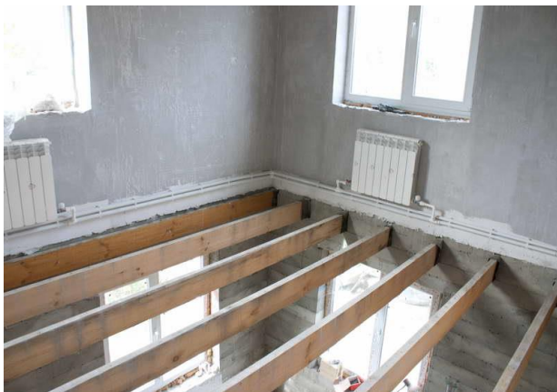
Рис. 50. Пример межэтажного перекрытия
