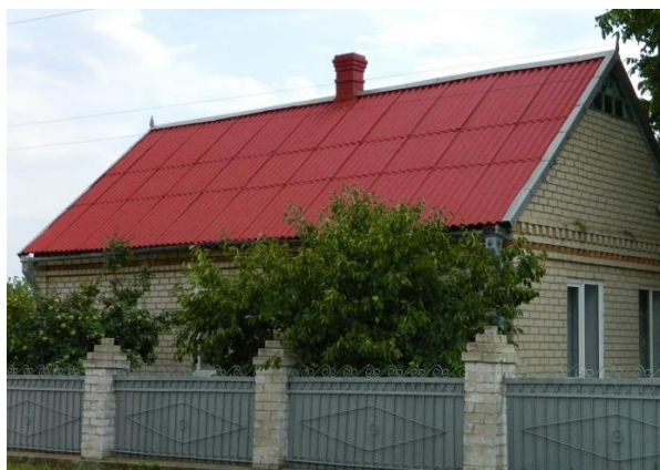
Рис. 121. Кровля из волнистых асбестоцементных листов
