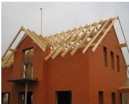
Рис. 96. Установка консольного прогона
