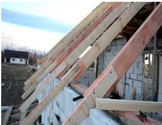
Рис. 104. Устройство кобылок
