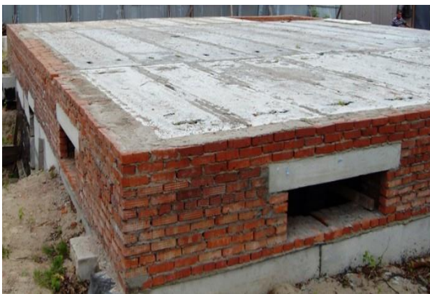
Рис. 51. Пример перекрытия над подвалом
