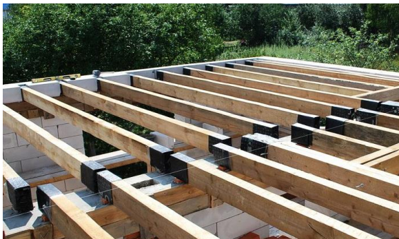
Рис. 57. Устройство перекрытия по деревянным балкам
