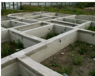
Рис. 36. Ленточные фундаменты по типу исполнения
