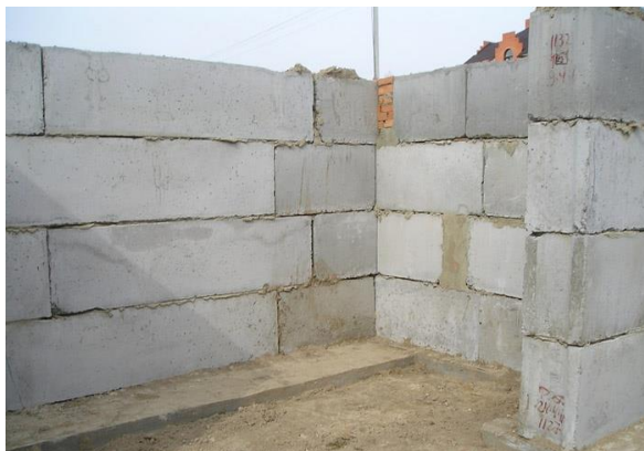
Рис. 48. Сборный ленточный фундамент
