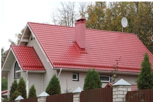
Рис. 107. Кровля из металлочерепицы
