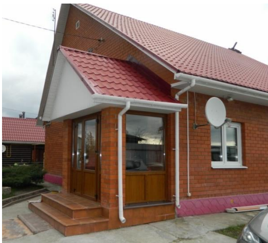
Рис. 160. Закрытая конструкция крыльца
