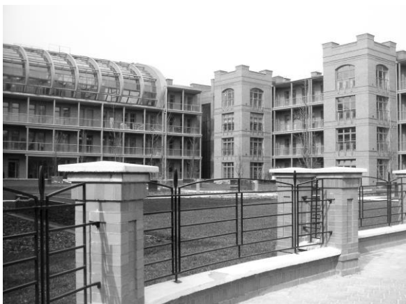
Рис. 3.2.6. Жилой комплекс «Сити-парк» (City Park) с плавательным бассейном и спортивно-оздоровительным центром на верхнем этаже жилого здания, подземным гаражем, на крыше которого расположен сквер (архитектурное бюро С. Росольского), г. Познань, Польша
