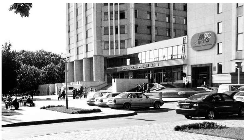
Рис. 3.3.1. Предзаводская площадь с местами кратковременного отдыха и автостоянкой перед Минским часовым заводом, г. Минск, Беларусь
