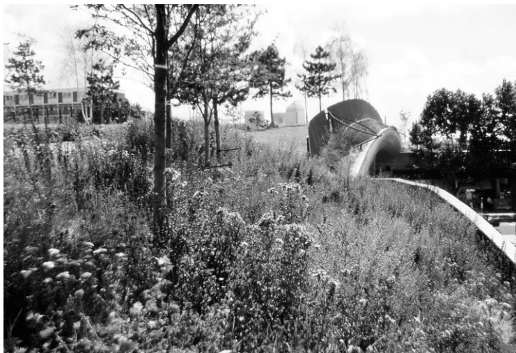
Рис. 3.5.2. Пересечение линейного парка с автомагистралью выполнено в разных уровнях и имеет земляное покрытие с посадками деревьев и кустарников, благодаря чему сохраняется пространственная целостность парка, г. Лондон, Великобритания
