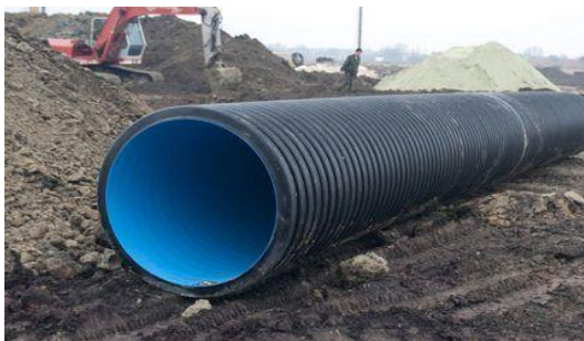
Рис. 16.3. Канализационная гофрированная труба
