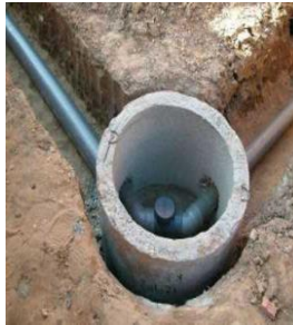
Рис. 15.4. Поворотный колодец
