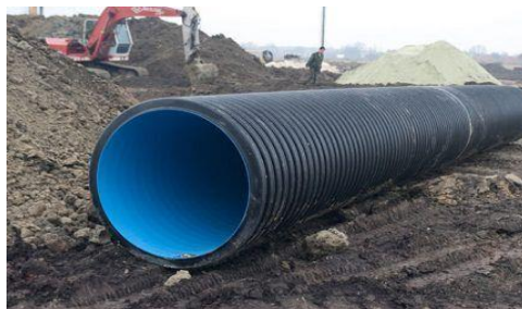
Рис. 7.3. Канализационная гофрированная труба
