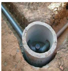
Рис. 6.4. Поворотный колодец
