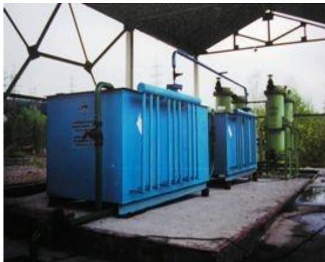
Рис. 7.9. Автоматическая насосная станция
