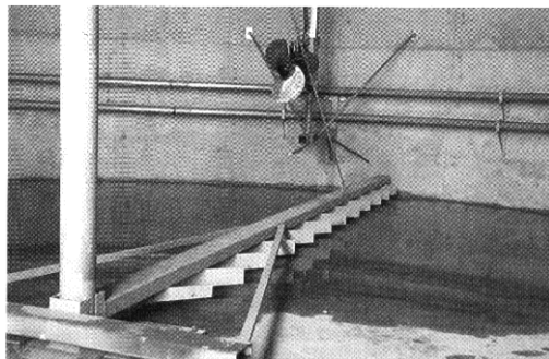
Рис. 5. Общий вид донного скребка для удаления ила из ферментатора
