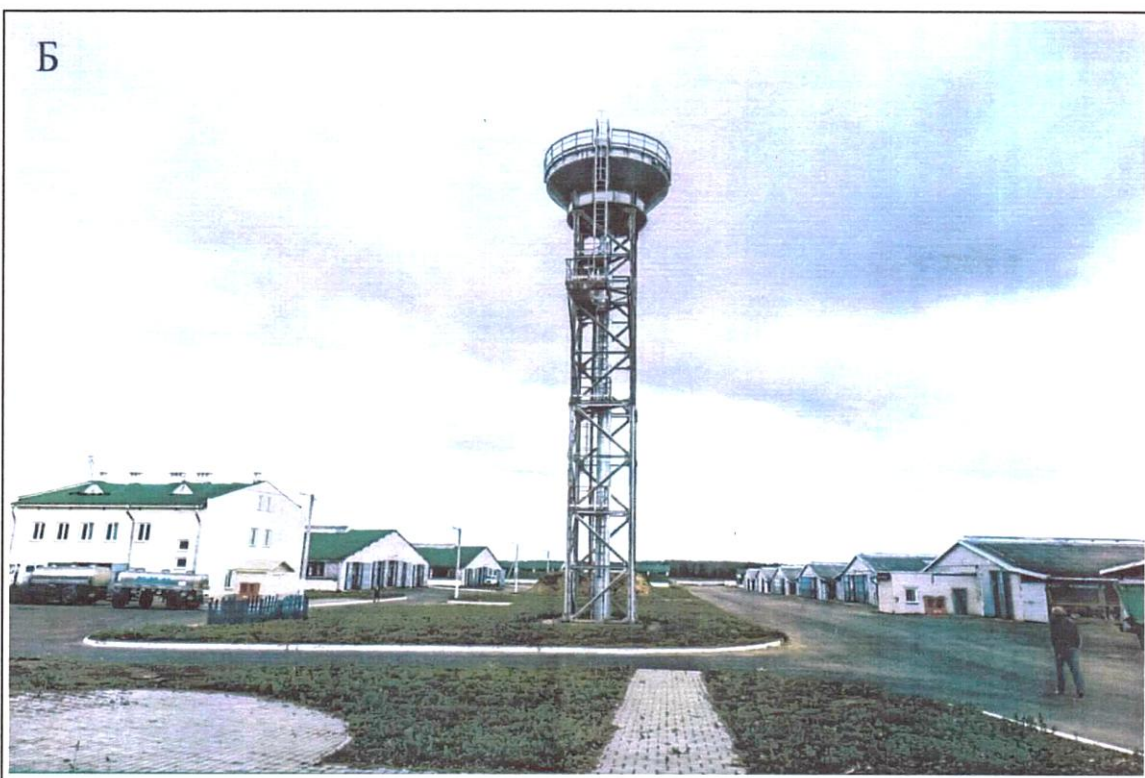
Рисунок 6.4 – Молочная ферма на 800 коров в агрогородке Тихиничи Рогачевского района: А – здание для содержания животных; Б – основные инженерные объекты: на переднем плане – водонапорная башня, слева – двухэтажное здание молочного блока
