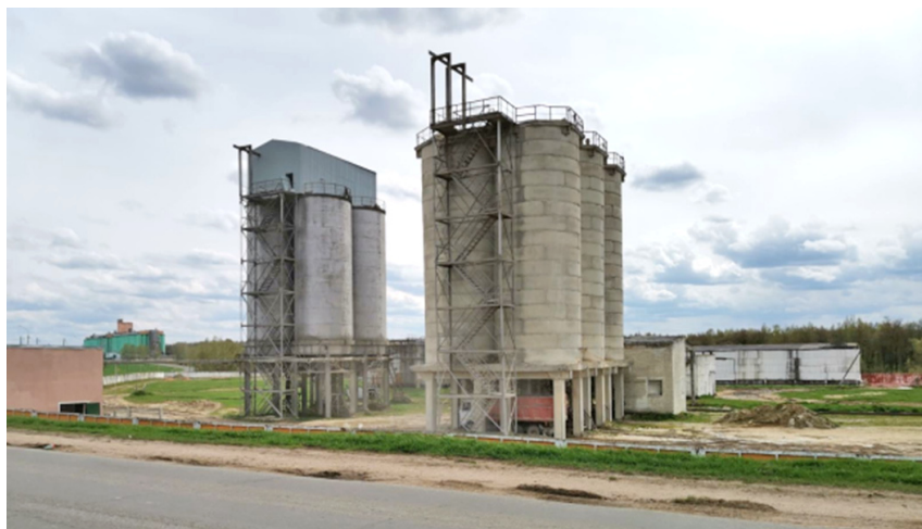
Рис. 7.1. Склады силосного типа для хранения доломитовой муки
