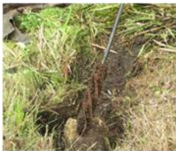
Рисунок 1 – Очистка устьевой части коллектора с применением насадки совковой и головки винтовой
