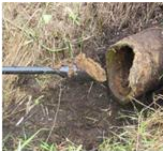
Рисунок 1 – Очистка устьевой части коллектора с применением насадки совковой и головки винтовой
