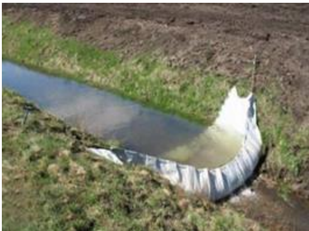
Рисунок 1 – Мягкая плотина МП-1
