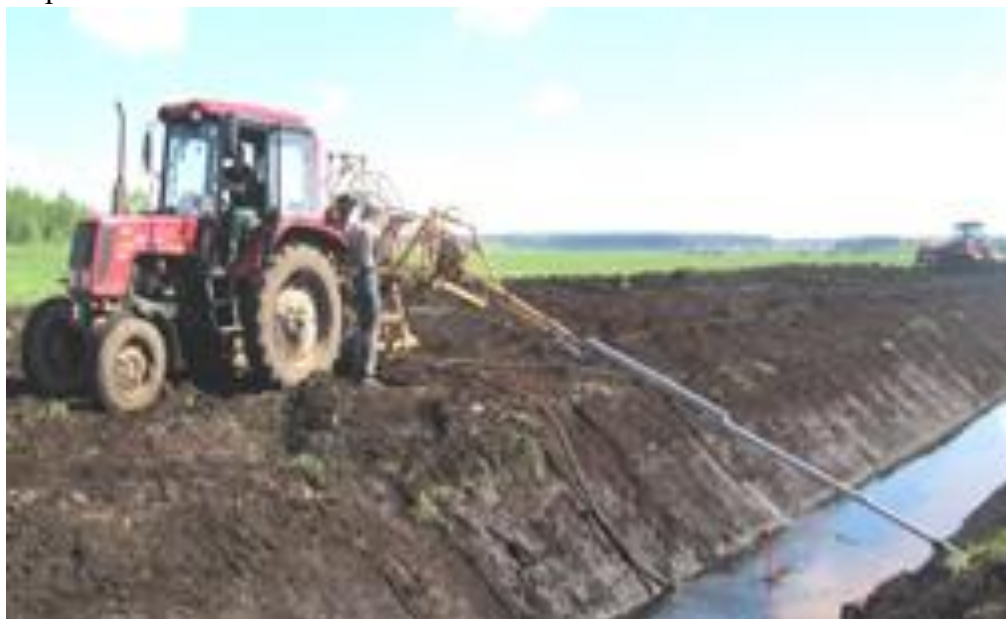
Рисунок 2 – Промывка коллекторной сети с применением направляющего устройства УНТ-6
