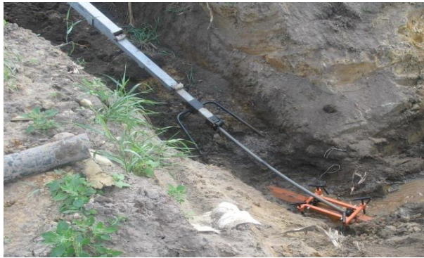
Рисунок 3 – Промывка коллектора через муфту промывочную МПГ-1 с применением направляющего устройства УНТ-6.
