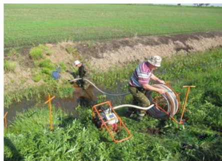
Рисунок 4 –Промывка коллектора с применением установки УПК-30
