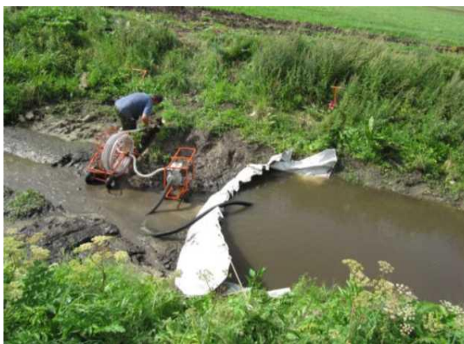
Рисунок 2 – Промывка устьевой части коллектора установкой УПК-30 с применением мягкой плотины МП-1
