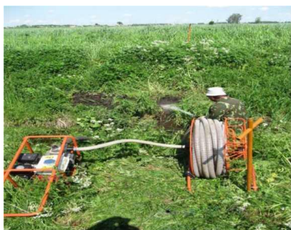
Рисунок 3 – Очистка дренажного устья от заиления установкой УПК-30 с применением прямоточной головки.
