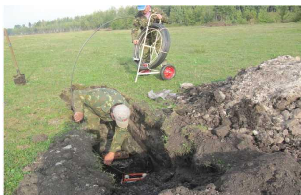
Рисунок 6 – Оценка внутреннего состояния коллектора из шурфа с применением устройства ОД-100 и муфты промывочной МФГ-1.
