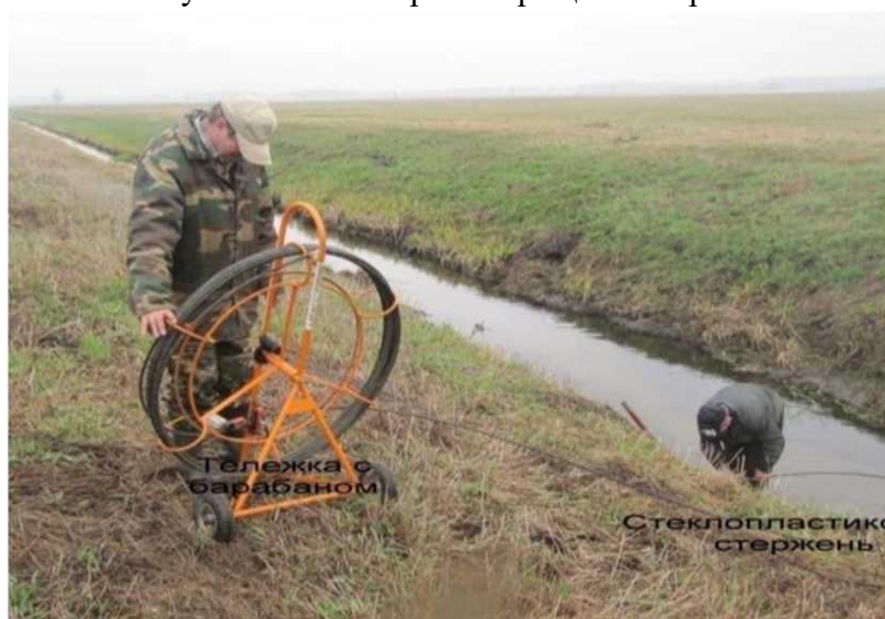
Рисунок – Оценка внутреннего состояния коллектора с применением устройства ОД-100.
