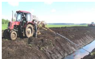
Рисунок 8 – Промывка коллекторной сети с применением направляющего устройства УНТ-6
