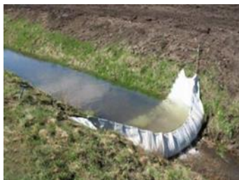
Рисунок 6 – Мягкая плотина МП-1
