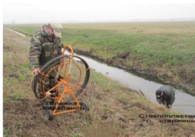
Рисунок 1 – Оценка внутреннего состояния коллектора с применением устройства ОД-100.
