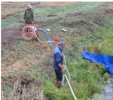
Рисунок 4– Размыв отложений с применением установки УПК-30 и мягкой плотины МП-1
