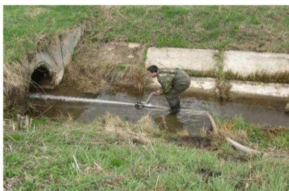
Рисунок 9 – Размыв отложений в полости сооружения с применением гидромонитора ГМ-1 при нижнем уровне расположения ствола
