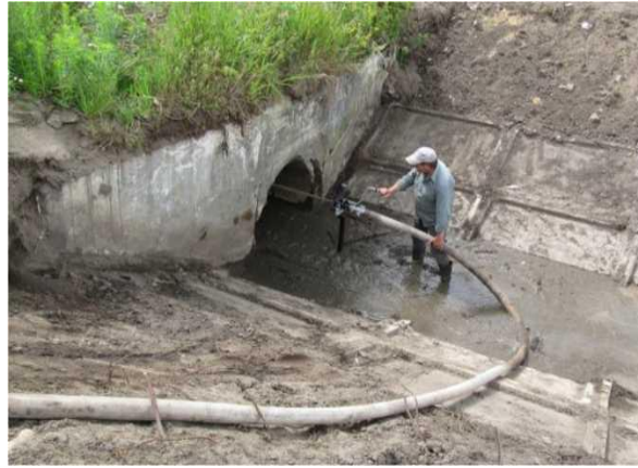
Рисунок 10 – Промывка отложений в полости трубы-переезда при установке гидромонитора ГМ-1 на опоре
