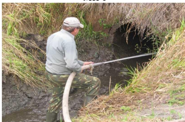
Рисунок 5– Размыв отложений в трубе-переезде с применением установки УПК-30 с ис-
