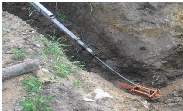
Рисунок 15 – Промывка коллектора через муфту промывочную МПГ-1 с применением направляющего устройства УНТ–6.
