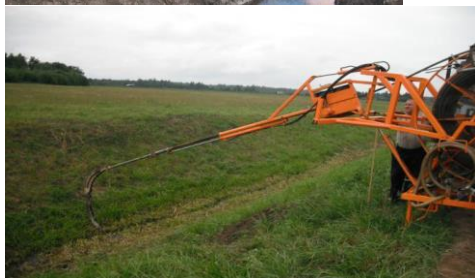
Рисунок 14 – Промывка дренажного коллектора установкой УПД-120 с применением направляющего устройства конструкции ОАО «Пинский завод СММ».
