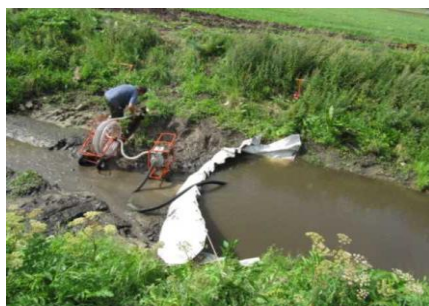
Рисунок 21 – Промывка устьевой части коллектора установкой УПК-30 с применением мягкой плотины МП-1
