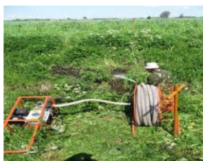
Рисунок 22 – Очистка дренажного устья от заиления установкой УПК-30 с применением прямооточной головки.
