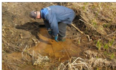
Рисунок 17 – Очистка коллектора от окисных соединений железа с применением насадки мягкой
