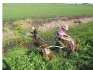
Рисунок 23 – Промывка коллектора с применением установки УПК-30
