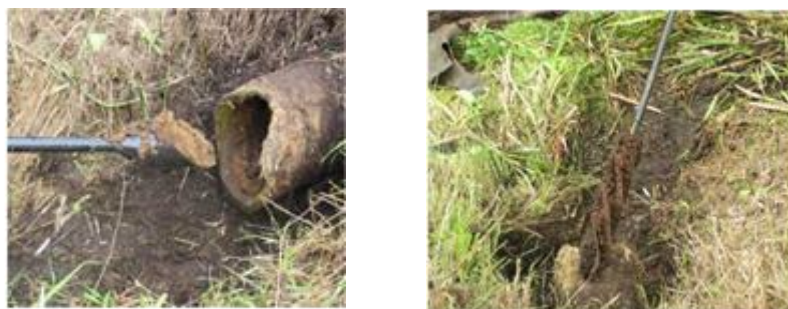
Рисунок 1 – Очистка устьевой части коллектора с применением насадки совковой и головки винтовой
