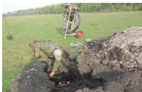
Рисунок 8 – Оценка внутреннего состояния коллектора из шурфа с применением устройства ОД-100 и муфты промывочной МПГ-1.
