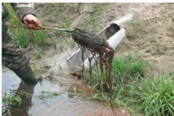
Рисунок 2 – Извлечение корней растений из устьевой части коллектора с применением насадки НК-1
