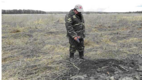
Рисунок 5 – Поиск места неисправности в дренажном коллекторе с применением поискового устройства «TRASKA»
