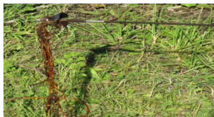
Рисунок 4.18 – Извлеченные корни растений из коллектора насадкой НМ-80
