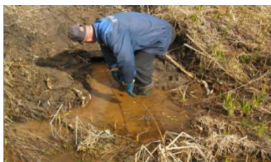
Рисунок 4.17 – Очистка коллектора от окисных соединений железа
