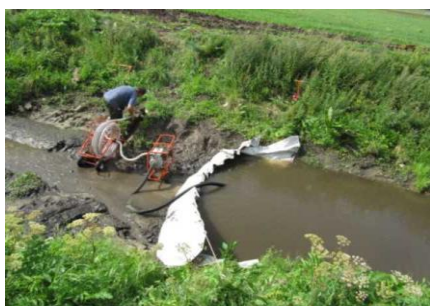
Рисунок 4.21 – Промывка устьевой части коллектора установкой УПК-30 с применением мягкой плотины МП-1
