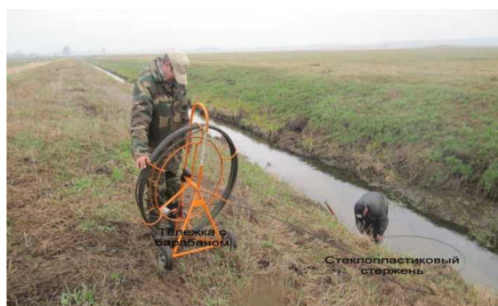
Рисунок 3 – Оценка внутреннего состояния коллектора с применением устройства ОД-100
