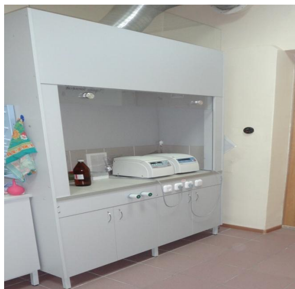
Рис. 9. Вытяжной шкаф с центрифугами
