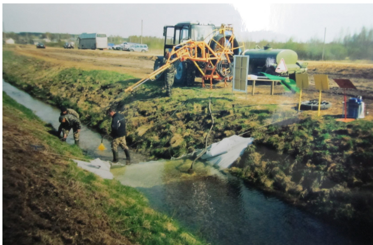
Рис. 5.20. Промывка дрен и коллекторов от наносов дренопромывочной машиной УПД-120
