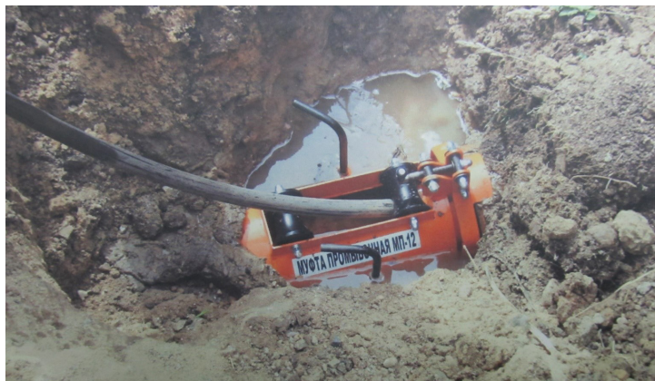
Рис. 5.22. Муфта промывочная МП-12
