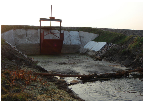
Рис. 3.4. Скопление бузы перед трубой-регулятором
