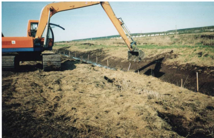
Рис. 5.10. Очистка канала от наносов экскаватором ЭО-3223
