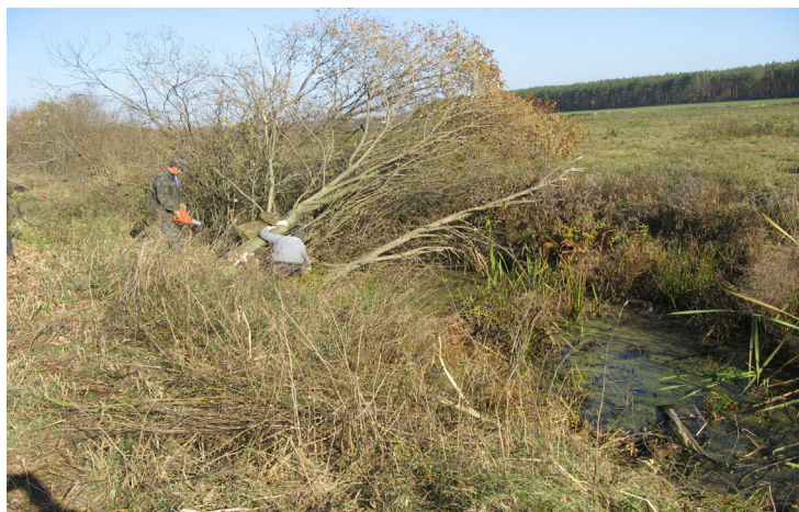
Рис. 5.3. Валка деревьев на откосах каналов бензопилами
