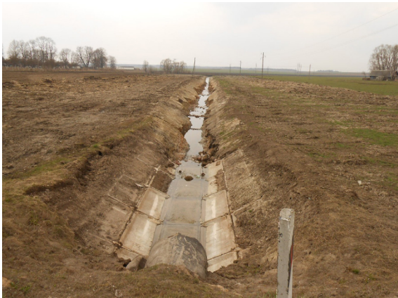
Рис. 3.2. Размыв канала потоком воды
