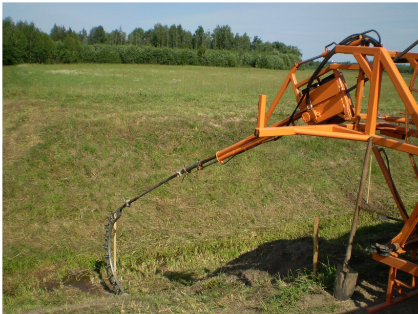
Рис. 5.24. Промывка дренажных коллекторов с применением направляющего устройства
