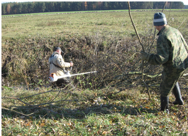
Рис. 5.2. Сводка древесно-кустарниковой растительности кусторезами «Хускварна»
